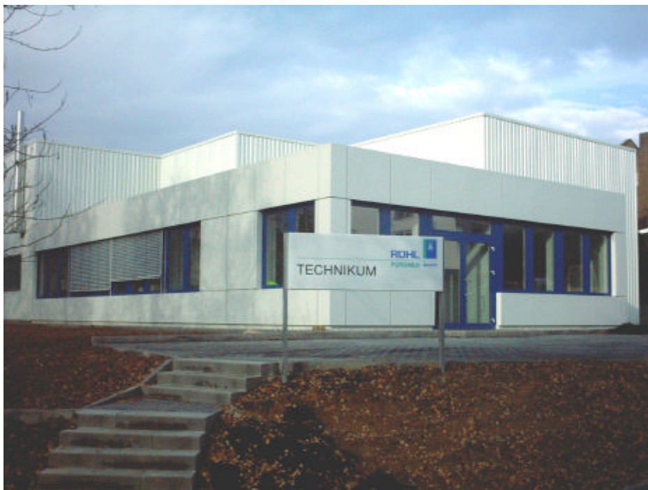
Das neue Technikum
